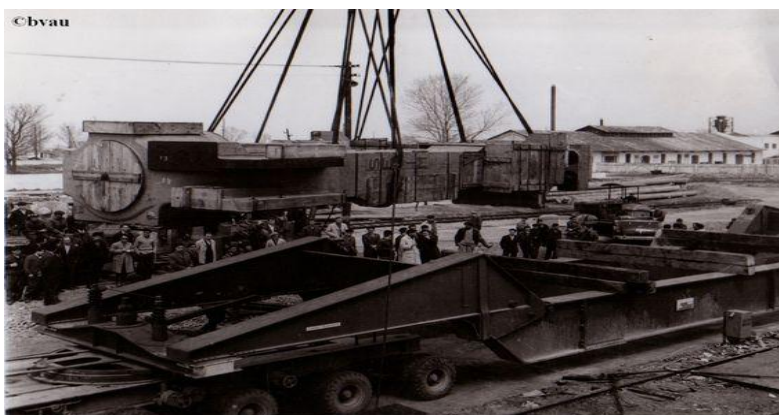
FOTO 5 – CADRUL CAJEI FINISOARE DE LA LTG 1 SE ÎNCARCĂ PE TRANSPORTOR
