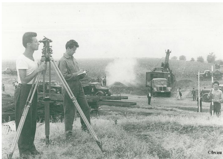
FOTO 2 – SE FAC MASURATORI TOPOMETRICE PE DEALUL FĂLOAIA
