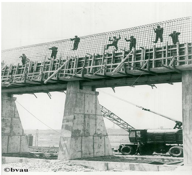
FOTO 14 – VIADUCTUL DE LA CĂUȘA ÎN CONSTRUCȚIE
